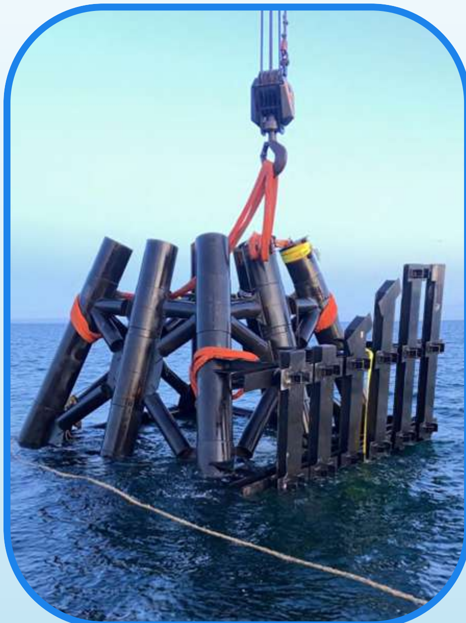
Estructura jacket Poste de Amarre, montada terminal Prat
