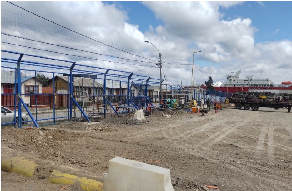
Fotografía 2 Avance de 44% al 31.12.2022 en obras civiles para instalar paneles
