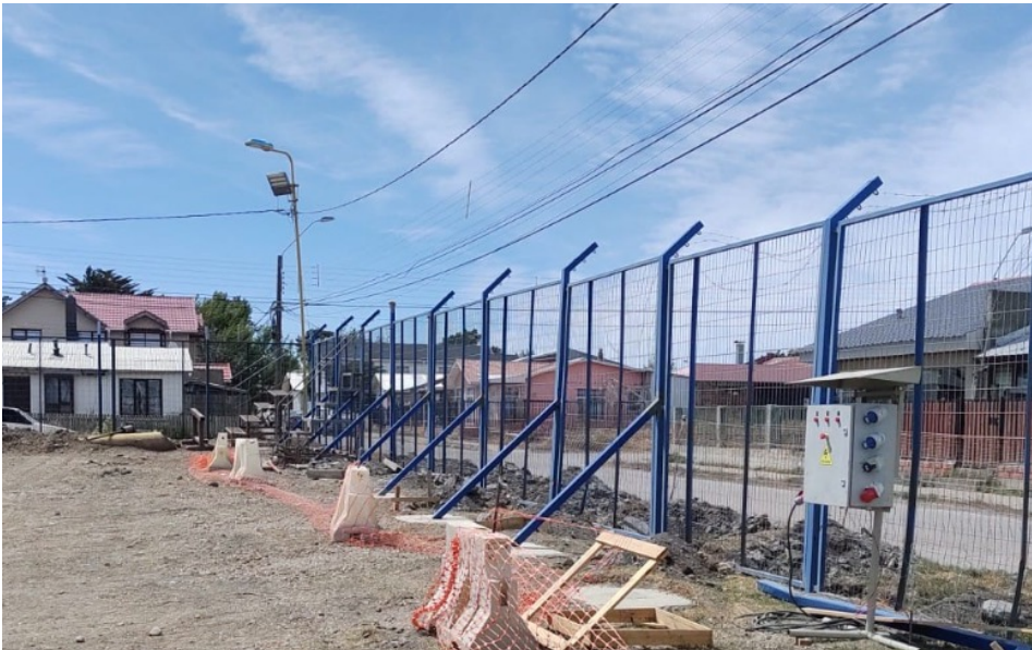
Fotografía 3 Avance de 44% al 31.12.2022 en obras civiles para instalar paneles
