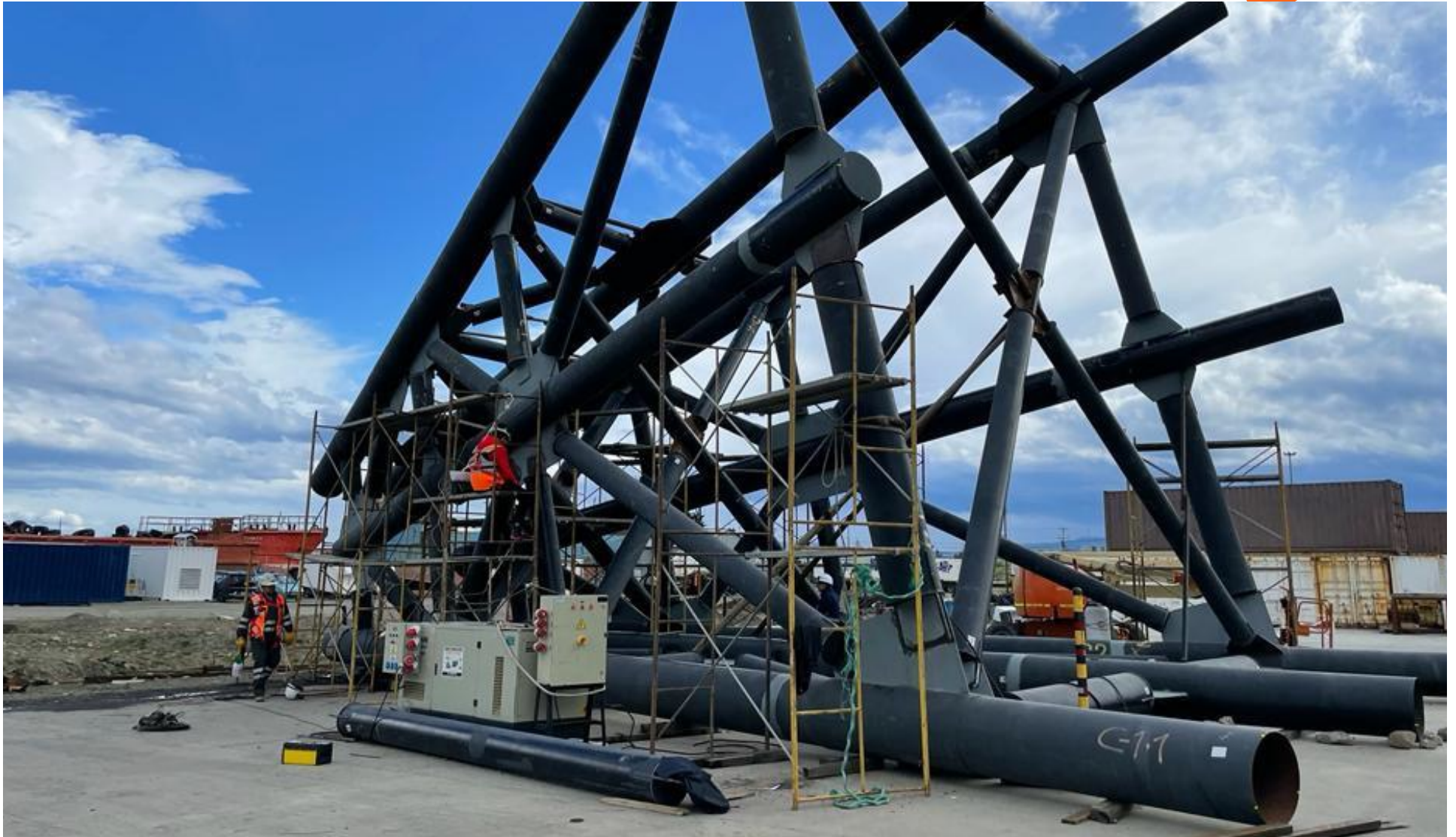
Fotografía 3 Proceso de fabricación jacket Dolphin Nro. 3
