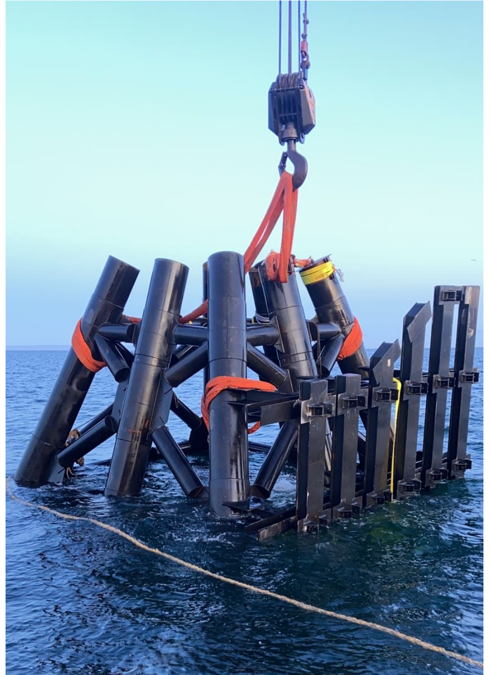
Fotografía 2 Estructura jacket Poste de Amarre, recién montada terminal Prat
