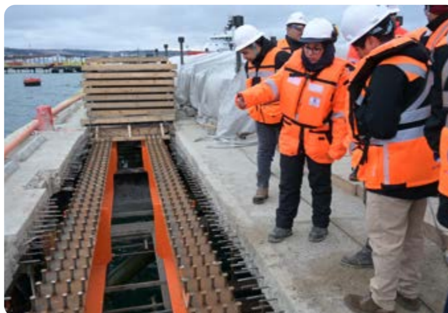
Los trabajos de mejora en la losa del Muelle Mardones implican un refuerzo estructural integral, basado en la instalación de vigas y elementos de soporte. Esta intervención se ha realizado en paralelo a las operaciones habituales del principal terminal de carga de Magallanes.
