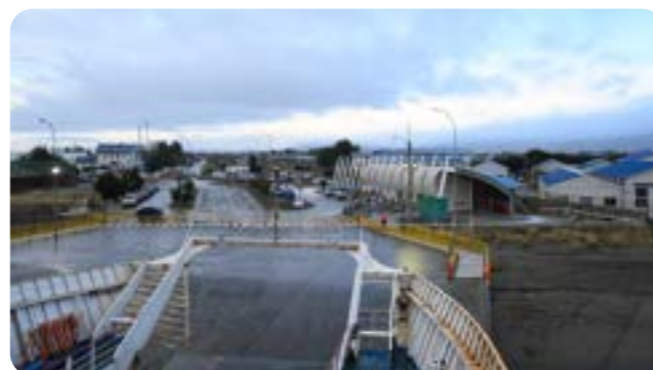
Rampa Tres Puentes.
