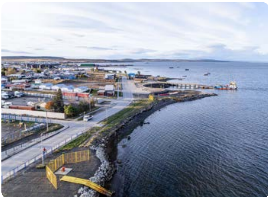
Rampa Puerto Natales.
