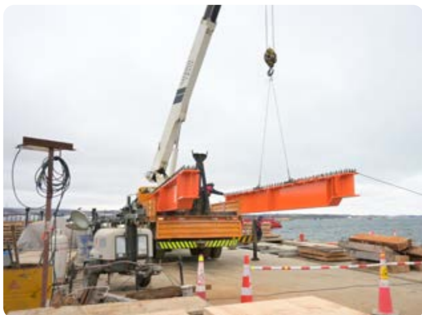
Los trabajos de mejora en la losa del Muelle Mardones implican un refuerzo estructural integral, basado en la instalación de vigas y elementos de soporte. Esta intervención se ha realizado en paralelo a las operaciones habituales del principal terminal de carga de Magallanes.
