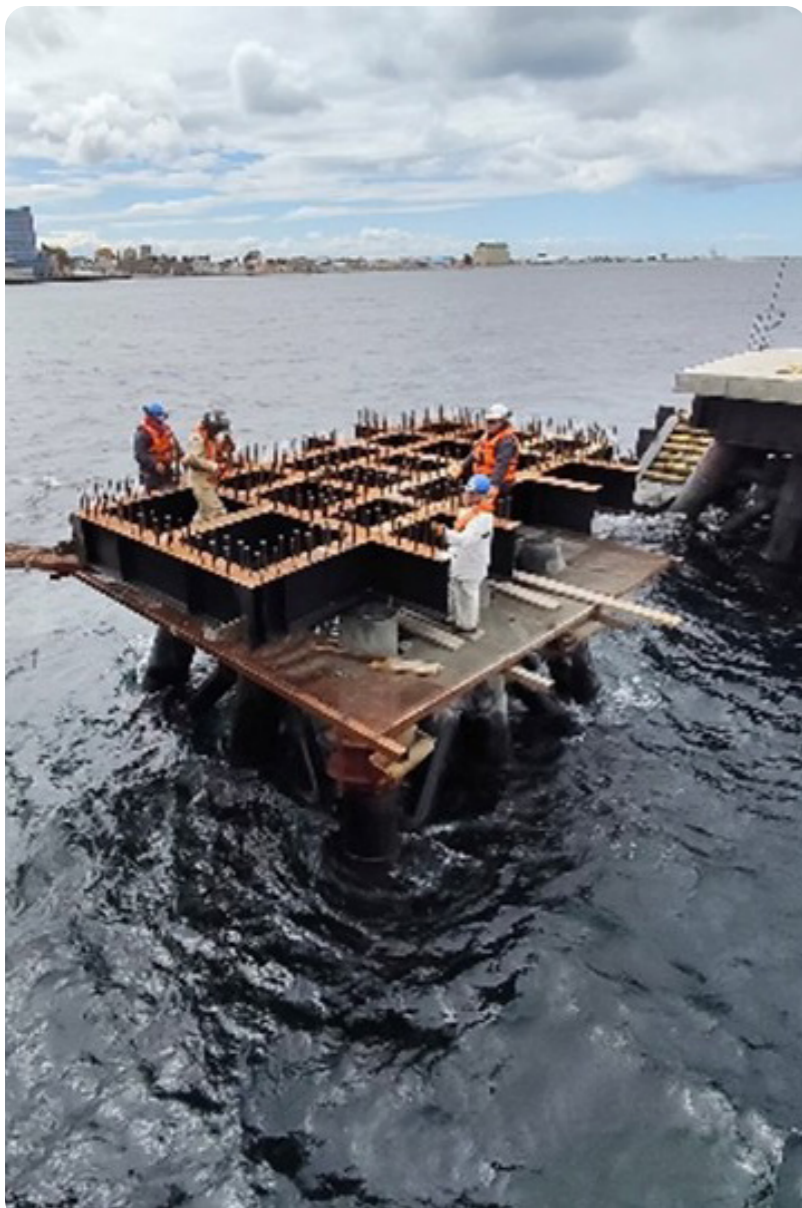
Trabajos Estructura jacket Dolphin Nro. 3 - Terminal Arturo Prat - Punta Arenas.
