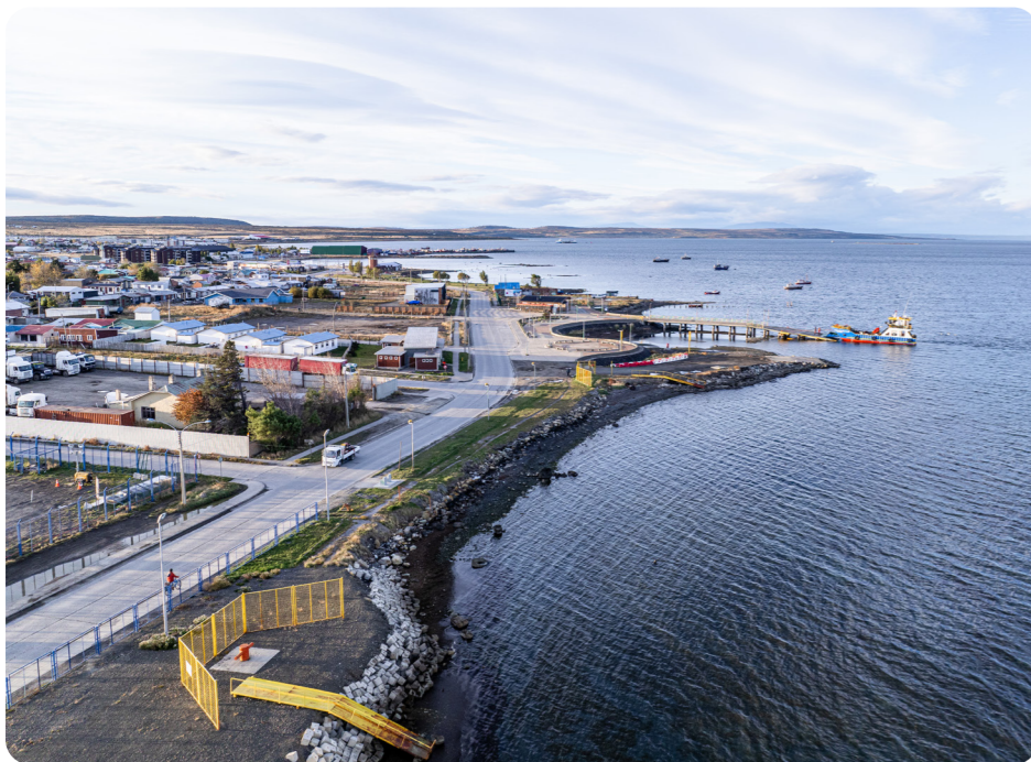
Rampa Puerto Natales.
