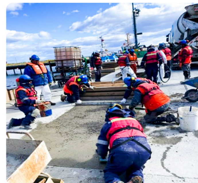
Los trabajos de mejora en la losa del Muelle Mardones implican un refuerzo estructural integral, basado en la instalación de vigas y elementos de soporte. Esta intervención se ha realizado en paralelo a las operaciones habituales del principal terminal de carga de Magallanes.
