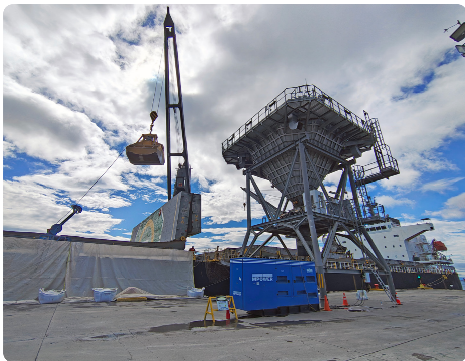
Terminal José de los Santos Mardones - Punta Arenas.
