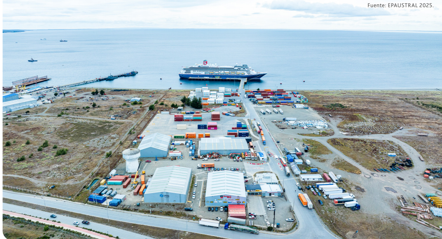
Terminal José de los Santos Mardones - Punta Arenas.
