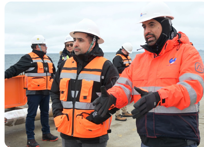
Visitas a Terreno - Obras Mejoramiento de Losas en Terminal Mardones.
